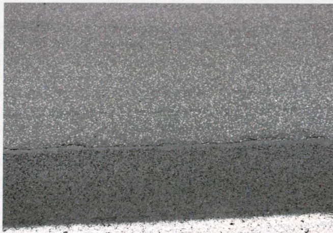
Bild 3: A 7 AS Cuxhagen, Gussasphaltdeckschicht und erneuerter Standstreifen aus SMA (Quelle: A. Lubach)
