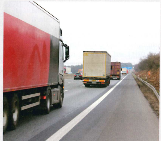
Bild 2: A 7 AS Cuxhagen, Deckschicht aus Gussasphalt, Bj. 1975 (Quelle: A. Lubach)
