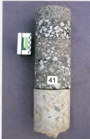
Bild 1: Bohrkern A 100, Fahrbahnaufbau mit Gussasphaltdeckschicht, Bj. 1958 (Quelle: Senatsverwaltung für Stadtentwicklung und Umwelt, Berlin)
