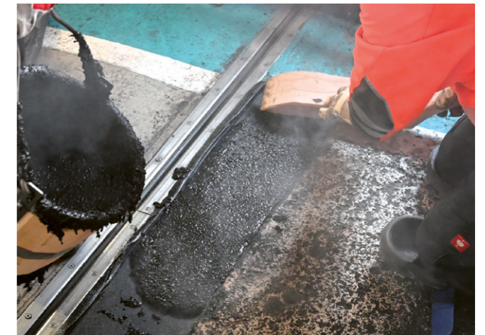
Einbau von Gussasphalt (HMG gemäß H RepA)
