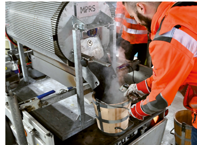
Aufbereitung von Gussasphalt (HMG gemäß H RepA) mit MP RS
