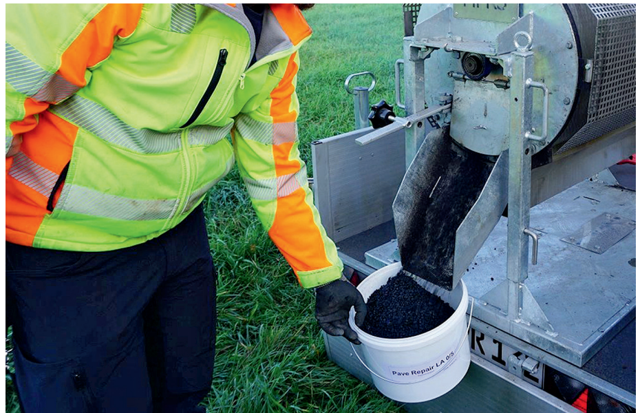
Entnahme von Pave Repair LA-Mischgut (WMG)
