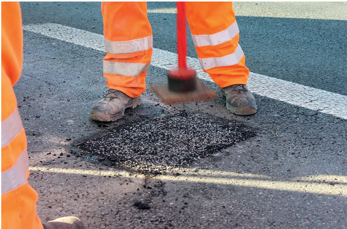
Verfüllen mit MPRS (Quelle: Carl Ungewitter)
