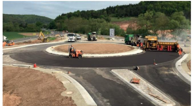
Abb. 2 Einbau von Gussasphalt im Kreisverkehr
