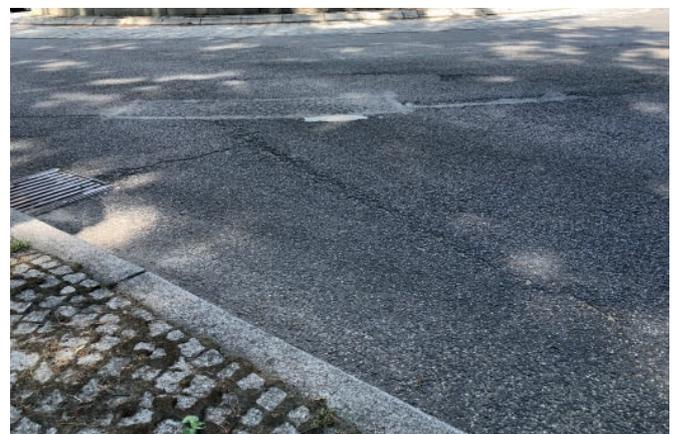
Abb. 1 Kreisverkehrsplatz mit stark geschädigter SMA-Deckschicht
