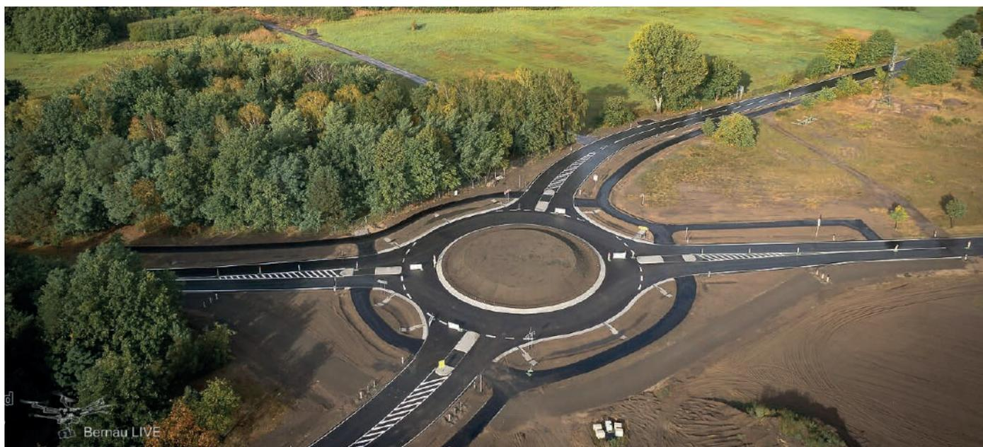
Abb. 3: Fertiggestellter Kreisverkehrsplatz mit Gussasphaltdeckschicht (B 287 Wandlitz/Brandenburg)
