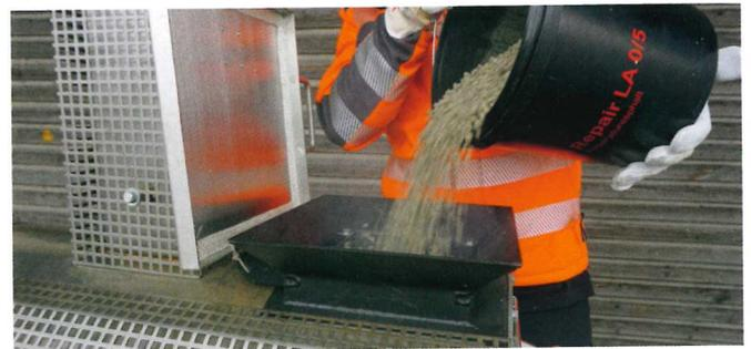
Befllen der Aufbereitungsanlage mit Asphaltpellets
